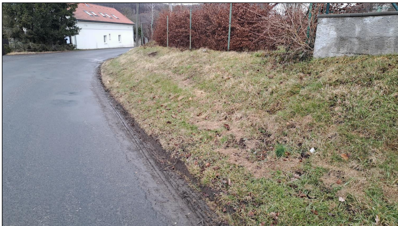
Foto 6: Silnice III/1044 - nefunkční odvodnění
