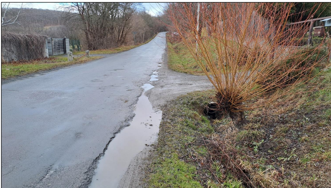
Foto 5: Silnice III/1044 – poruchy vlivem nefunkčního odvodnění
