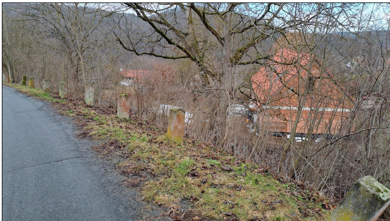
Foto 7: Silnice III/1044 - chybějící svodidlo
