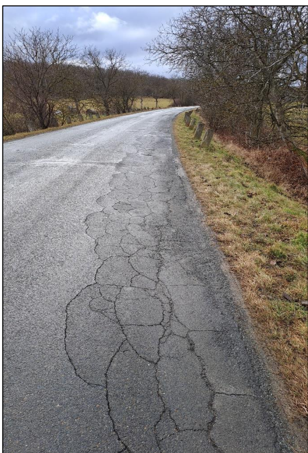
Foto 2: Silnice III/1044 - síťové trhliny
