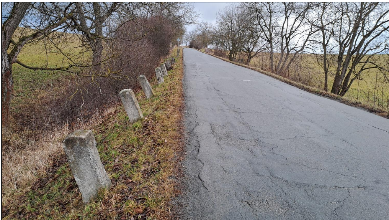
Foto 1: Silnice III/1044 - mozaikové trhliny
