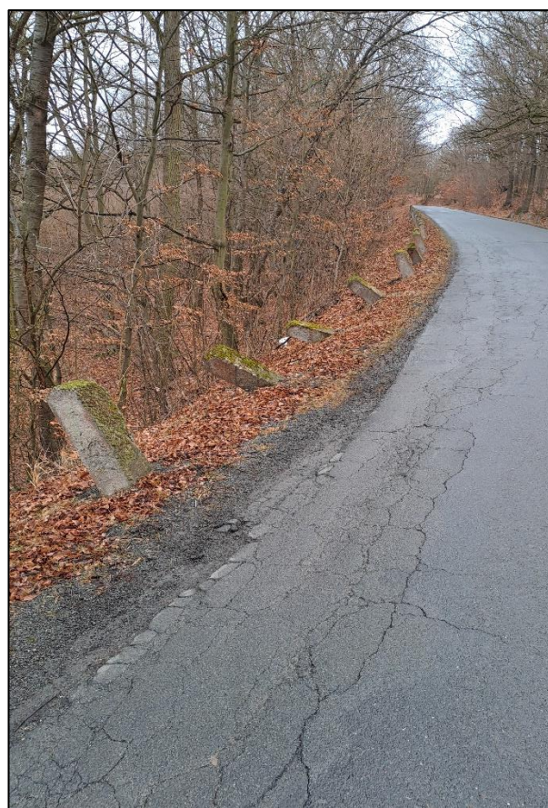
Foto 3: Silnice III/1044 - síťové trhliny,
