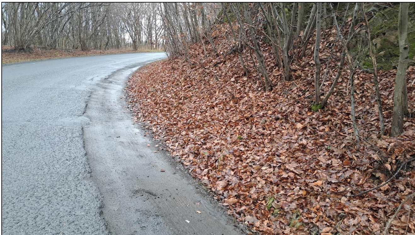
Foto 4: Silnice III/1044 – poruchy vlivem nefunkčního odvodnění
